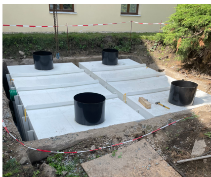
Obrázek: Nádrže na zachycování dešťové vody ze střech historické budovy
