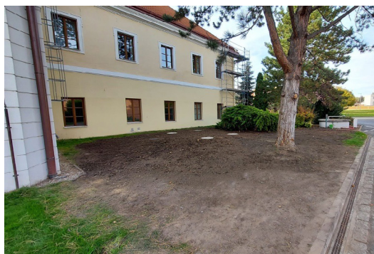
Obrázek: Nádrže na zachycování dešťové vody ze střech historické budovy
